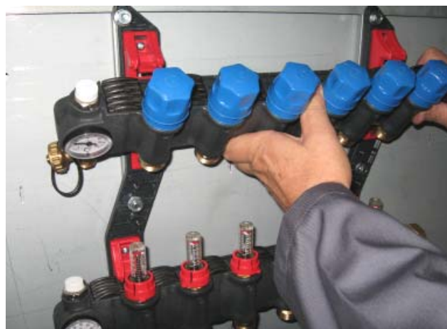
8) Rozdělovač vratného potrubí zavěste na vrchní úchyty
