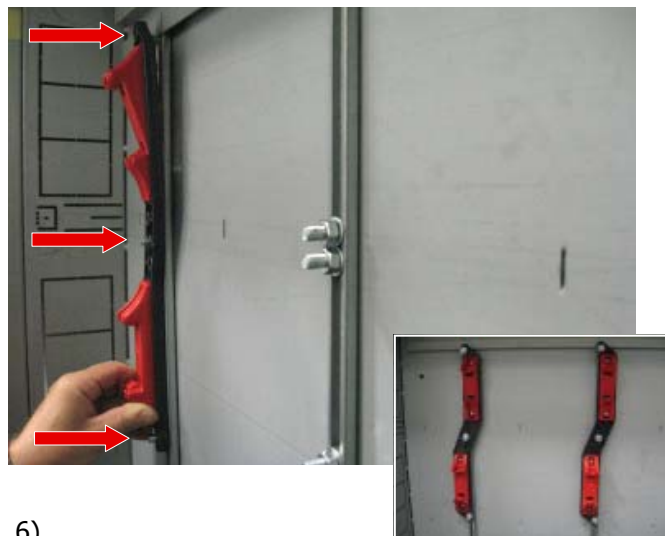
6) Připevněte plastové držáky do C-profilů
