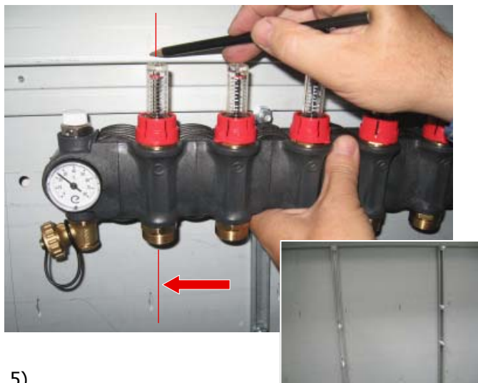
5) Umístěte C-profil na vhodnou pozici podle požadovaného umístění rozdělovače
