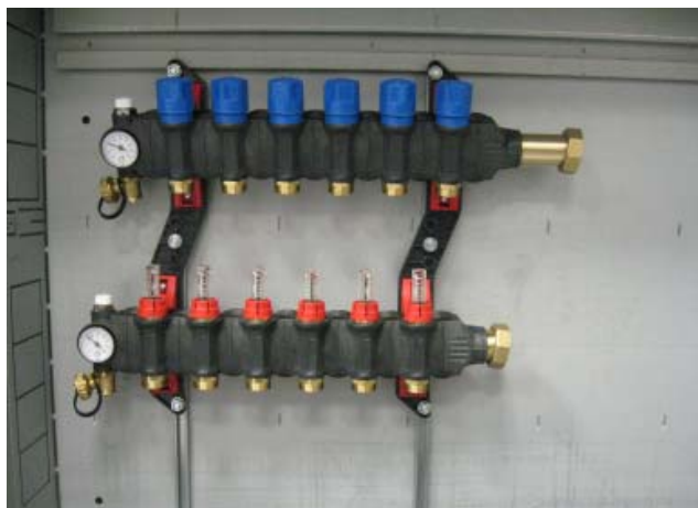
7) Zavěste rozdělovač přívodních trubek na spodní úchyty
