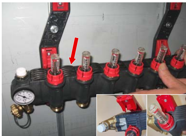
7) Zavěste rozdělovač přívodních trubek na spodní úchyty
